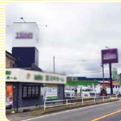
7月施工:屋上・自立サイン ティア矢作 様
