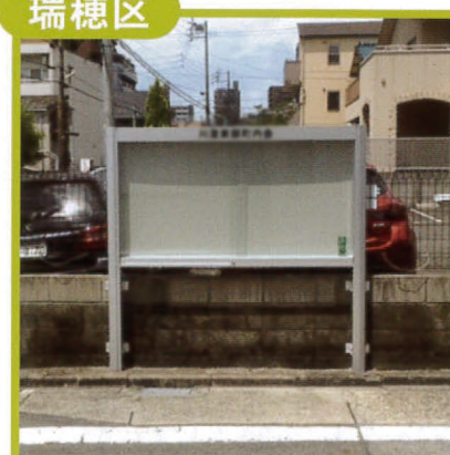
2018年6月施工：掲示板 川澄東部町内会 様
