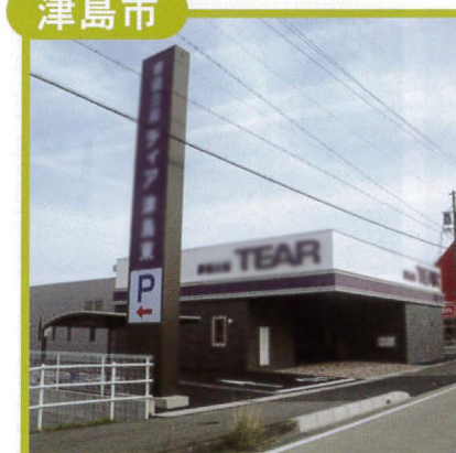
2018年4月施工：自立&壁面サイン ティア津島東 様
