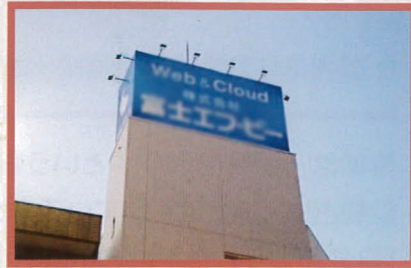
2017年11月施工 (株)富士エフ・ピー 様 屋上広告
