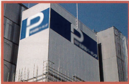
2017年12月施工 GS名駅南パーキング 様 住宅クリニックセンター 様 壁面書き文字
