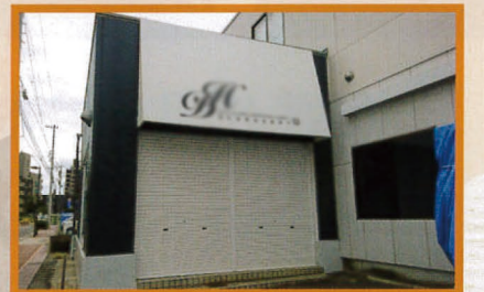
2017年9月施工 (株)ディアハート様 テントサイン
