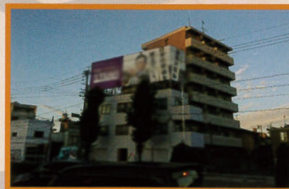
2017年9月施工 (株)ティア様 屋上広告塔
