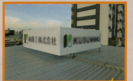
2017年7月施工 楠精工(株)様 屋上広告塔
