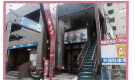
2017年4月施工 (株)繁昌様 ファサード・自立サイン等
