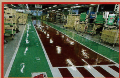
2016年12月施工 豊田合成(株) 春日工場 様 床面特殊フィルム貼り
