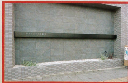
2016年11月施工 グランシャシオ城見 様 (住宅クリニックセンター様) 内照式BOXサイン
