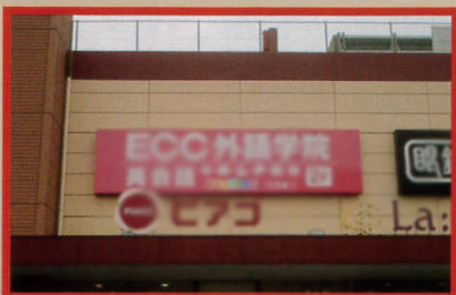
2016年11月施工 ECC 三河安城校 様 壁面サイン
