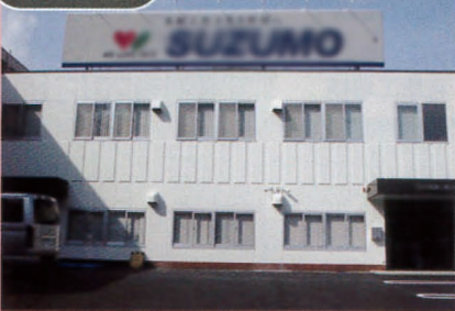
2015年10月施工 鈴茂器工株式会社 様 屋上広告
