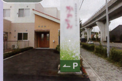
2014年6月施工 住宅型有料老人ホームかわかみ様 自立サイン
