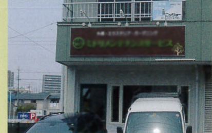
2014年4月施工 (有)ミドリメンテナンスサービス様 ファサードサイン
