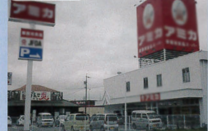
2014年5月施工 業務用食品スーパー アミカ 様 屋上広告塔、自立サイン、壁面サイン
