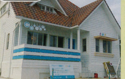
2014年7月施工 Coulurs/ (株)クルール 様 吊り下げサインその他
