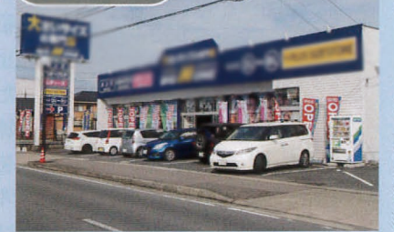
2013年10月施工 株式会社 ザザホラヤ様 新築サイン工事
