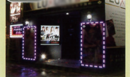
2014年3月施工 ラグジュアリー様 壁面サイン / LED モジュール
